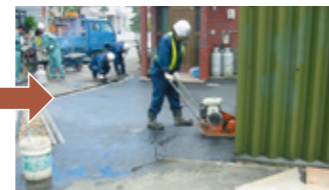
アスファルト仕上げ
