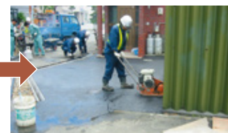
アスファルト仕上げ
