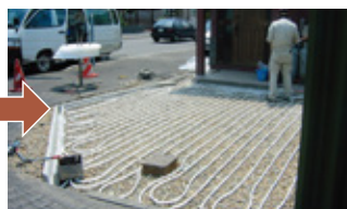
放熱管・架橋ポリパイプ敷設 ※電気式はヒーティングケーブル敷設
