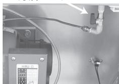
この際、灯油コックが開放位置(写真の状態)にあり、電源ブレーカーがON(入)にあることを確認して下さい。
